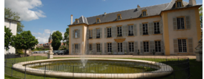
Le Château de Courcelles à Montigny-lès-Metz.
