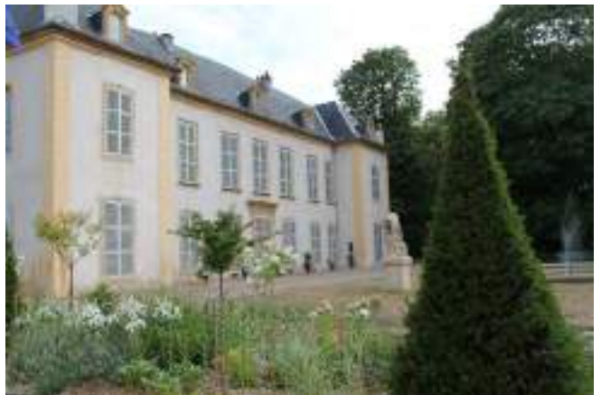
Le château de Courcelles de Montigny-lès-Metz
